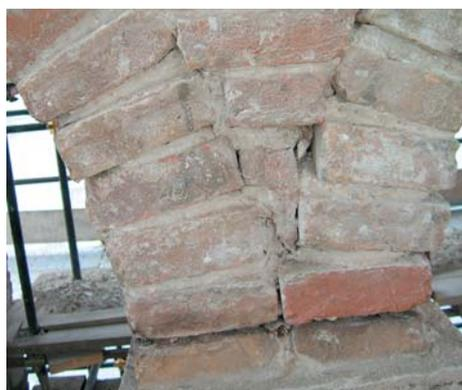
alla totale *scarnitura* delle stuccature ed alla rimozione delle *risarciture* realizzate a suo tempo con malta cementizia e sabbia di fiume. L'operazione veniva effettuata manualmente fatti salvi alcuni casi in cui non ci si poteva esimere per la specificità delle situazioni dall'uso di apparecchiature quali microtrapani e vibroscalpelli; strumenti comunque usati in modo tale da non produrre alcun danno al materiale da costruzione in posto.
